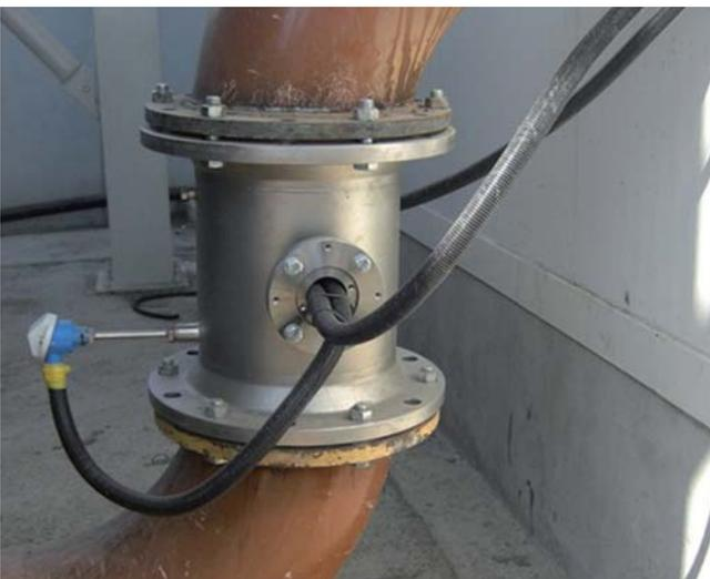
*Gerade die Zuckerindustrie im Bereich Rübenzuckerfabriken, Rohrmühlen und Rohzuckerraffinerien sowie Derivate – wie etwa Flüssigzuckeranlagen, Bioethanol-Herstellung oder Behandlung von Vinasse – profitiert von den exakten Dichte- und Konzentrationsmessungen, die das Verfahren ermöglicht. Rübenschlammmessungen können etwa mit einem DN300-Inlinemessrohr durchgeführt werden.*
